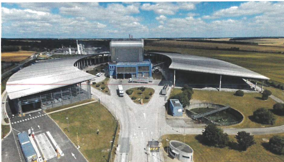
Installation du SYVALOM - Centre de tri à la VEUVE
