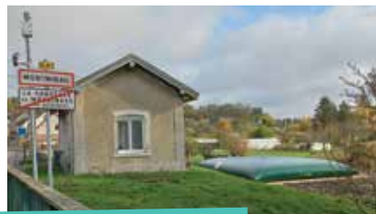
1» réserve incendie à La Chaussée de Mécringes
