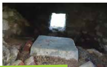
la pierre avec le petit trou pour vérifier l'aplomb du fil
