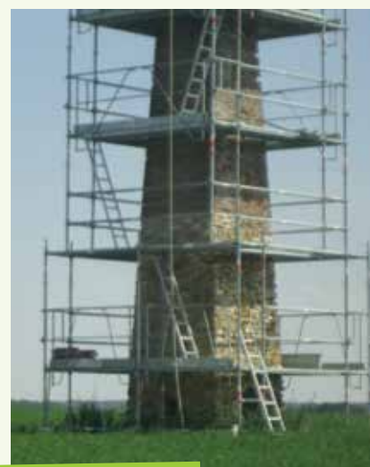
la tour de Champgillard pendant les travaux
