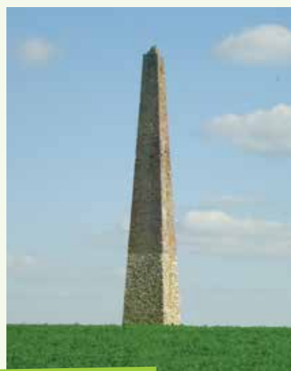
la tour de Champgillard avant travaux
