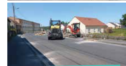
2» travaux de voirie rue de la Croix-Gaudé à Montmirail
