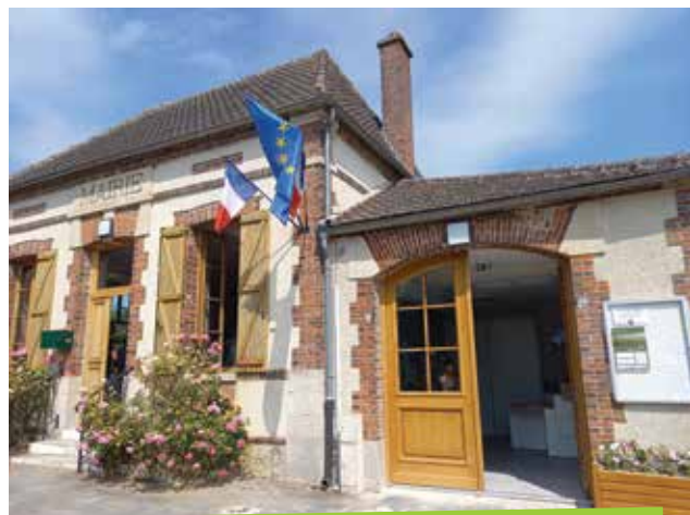
rénovation intérieure et remplacement des menuiseries extérieures
