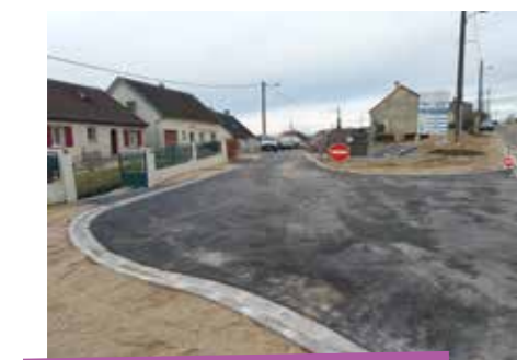
2» travaux rue des Vignes à Montmirail
