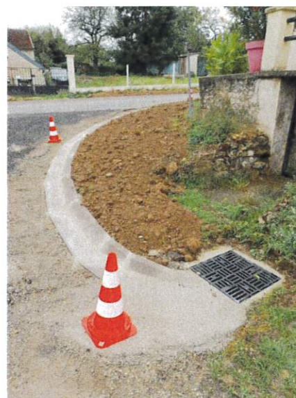
Assainissement pluvial rue de Montmirail - LE VÉZIER
