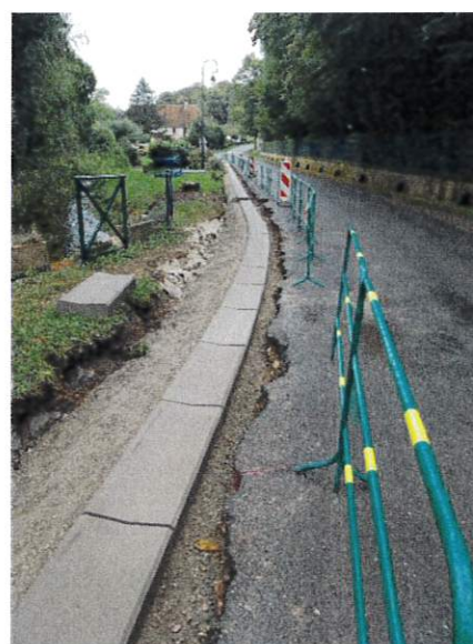
Assainissement pluvial rue de l'église - LE THOULT TROSNAY
