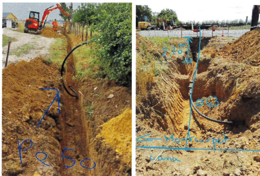
Travaux d'extension du réseau d'eau potable - La Dorgeaterie à MONTMIRAIL
