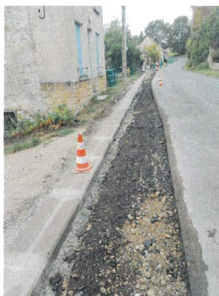
Travaux de voirie et d'assainissement pluvial - rue de la Verdonnelle - VERDON
